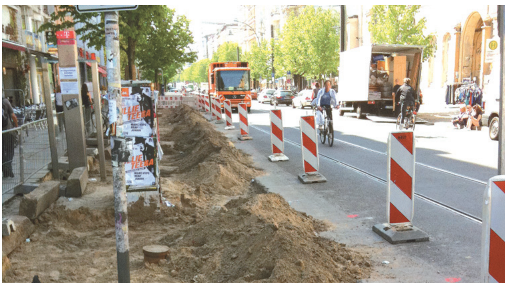
Der Stein des Anstoßes: die Bauarbeiten auf der Kastanienallee
