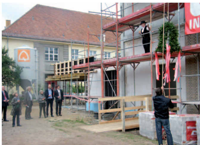
Endlich entsteht in Französisch Buchholz eine neue Turnhalle.
