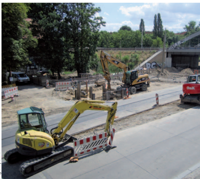
Aufgerissene Berliner Straße am S-Bahnhof Pankow
